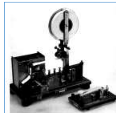
Un telegrafo Morse dei primi tempi. Questo apparecchio venne utilizzato lungamente anche nella nostra Isola
