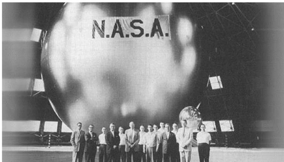
*Una stazione NASA in California si mette in contatto con un'altra stazione NASA in Florida. Per la prima volta, per comunicare telefonicamente, verrà utilizzato un ponte radio satellitare. A far rimbalzare le onde elettromagnetiche ci pensa un sfera gonfiabile metallizzata lanciata nella parte bassa dell'orbita terrestre, appartenente alla prima parte del progetto ECHO.*
