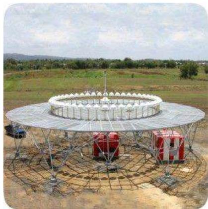
Una stazione di terra VOR utilizza un array di antenne a fasi per inviare un segnale alta-
