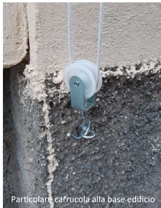
Filo di sostegno per mezzo dipolo filare
